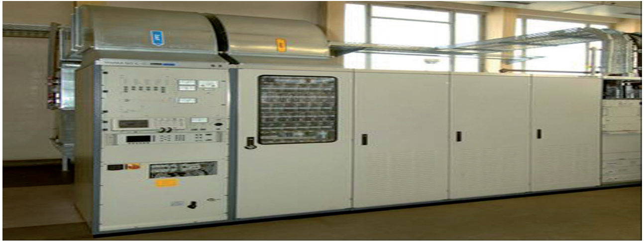
ภาพที่ ๕-๑๔ เครื่องส่งสัญญาณแบบกึ่งตัวนำ (Semi-conductor) ขนาด 50 kW
